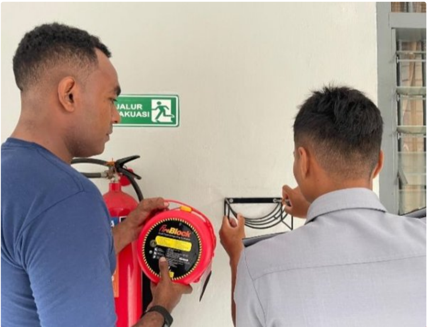
Antisipasi Kebakaran, Lapas Besi Tambah Pemasangan Fireblock
